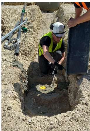
Einbau der Geophone im oberen Bereich der QBV
