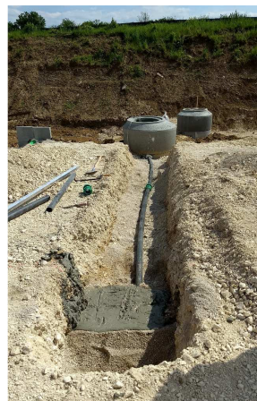
Einbau der Geophone im oberen Bereich der QBV
